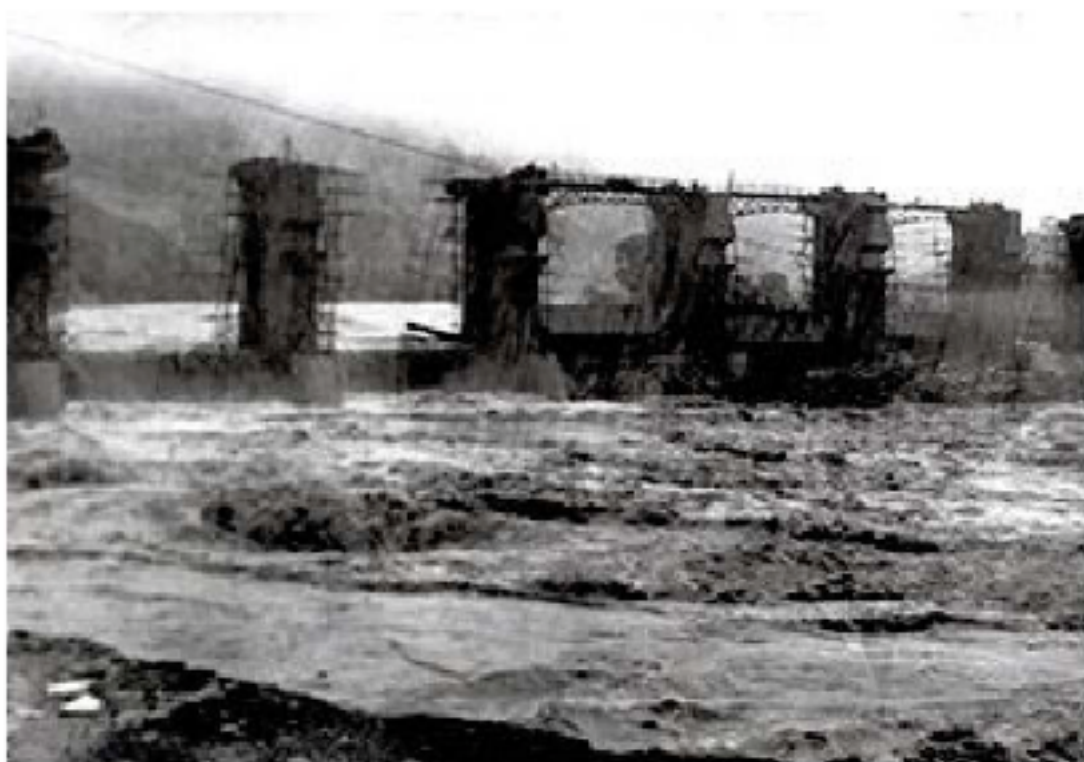
建設中の夜明ダムを襲った西日本大水害 1953(昭和28)年6月29日 所蔵:アソシエ地図の資料館(写真No. DYAK028)
