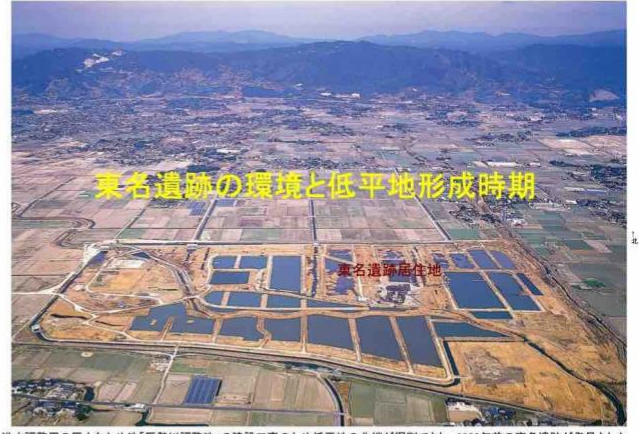
洪水調整用の巨大なため池「巨勢川調整池」の建設工事のため低平地の北端が掘削され、8000年前の東名遺跡が発見された。
